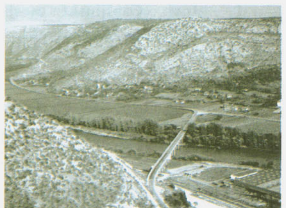
Žitomislić, most oštećen u trenutku rušenja Starog
