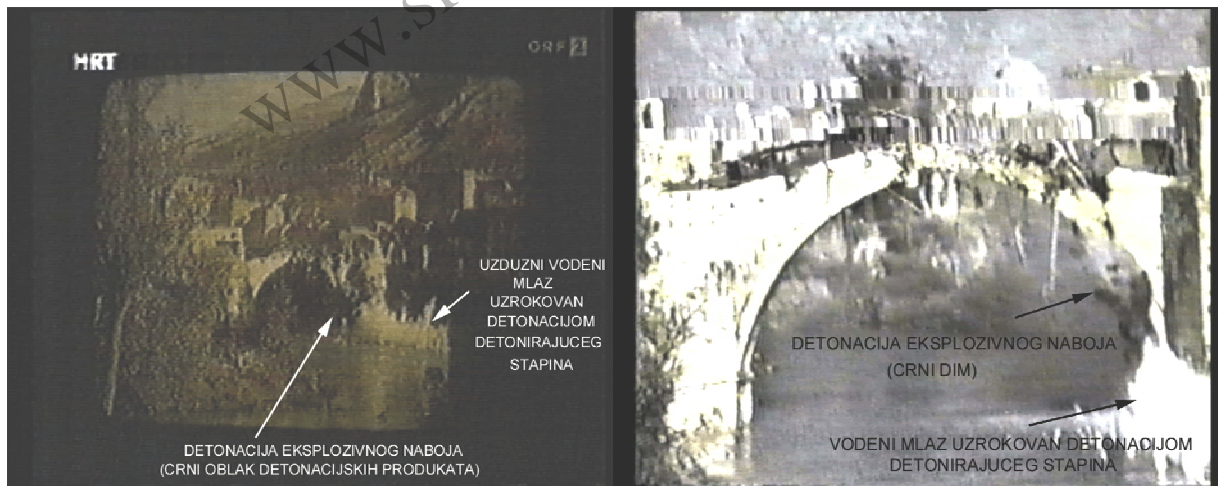
Slika 7. Vremenski slijed pojave uzdužnog vodenog mlaza i eksplozije u dnu luka mosta
