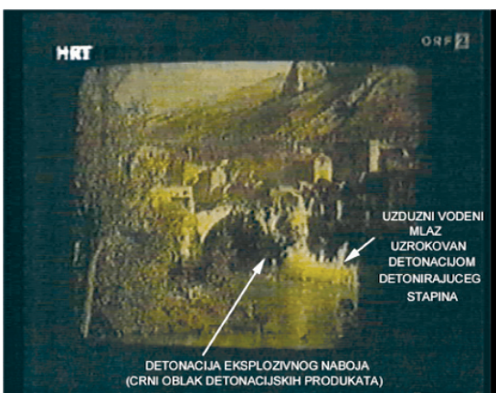
Slika 7. Vremenski slijed pojave uzdužnog vodenog mlaza i eksplozije u dnu luka mosta
