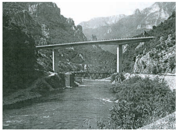
Vijadukt i most srušeni u trenutku rušenja Starog
