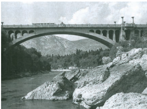
Carinski most, već srušen u trenutku rušenja Starog
